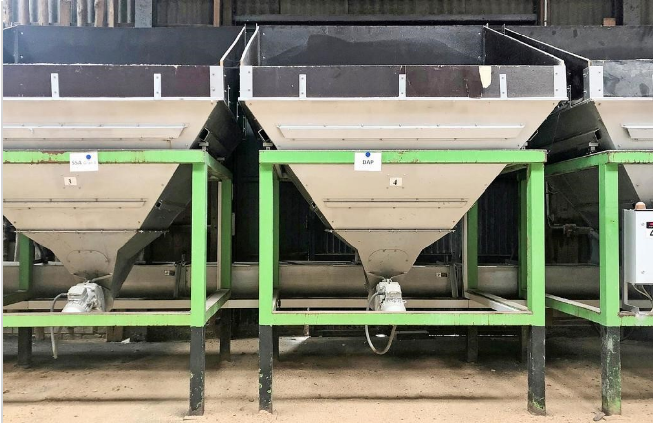
IN DER DÜNGERHALLE IN ALSFELD SIND SECHS BEHÄLTER ANEINANDERGEREIHT. FOTO: DA
