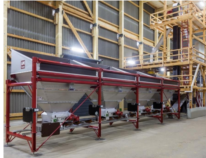
Hallenintegriert mit Düngerlager auf Befüllseite (rechts), Verladung links, Big-Pack- Absackung an Stirnseite
